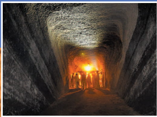
壕内の照明は太陽光発電を利用しています
